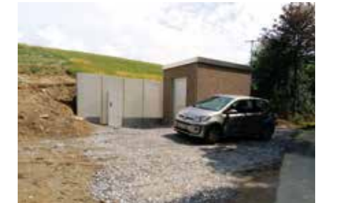
Neue Pumpstation Ortsnetz Tannenberg
