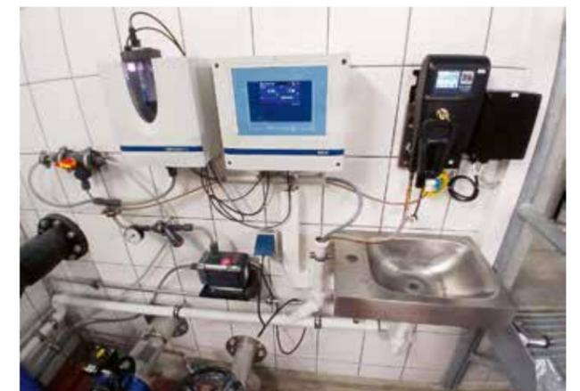
Abbildung 4: Online Chlor- und pH-Wert-Messzelle mit Anzeige in der TWA „Schurf 1“ in Geyer
