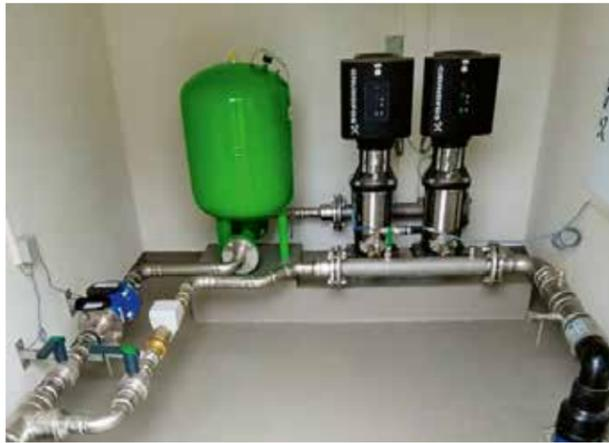
Abbildung 5: Druckerhöhungsanlage/ Pumpwerk Tannenber
