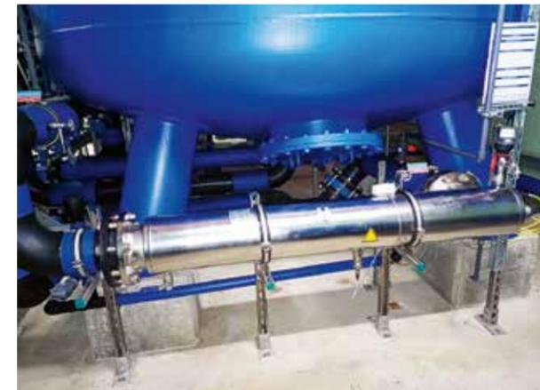
Abbildung 1: UV-Desinfektionsanlage in der TWA Am Pöhlberg (im Hintergrund einer der beiden Entsäuerungsdruckfilter)
