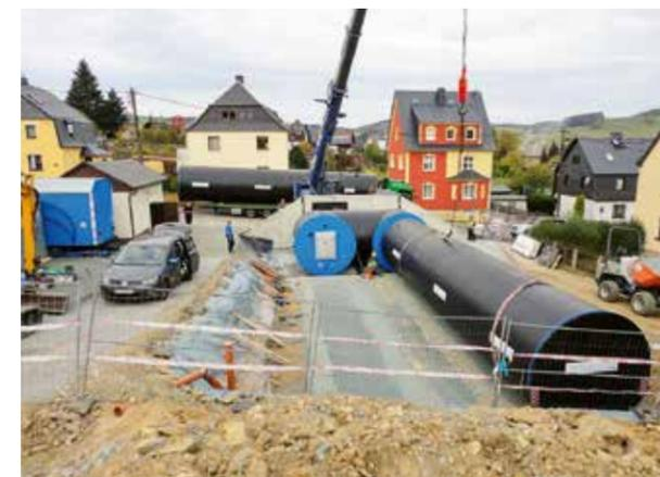
Abbildung 2: PE-Wickelrohrwasserbehälter mit Schieberkammer „Greifensteinstraße“ in Thum
