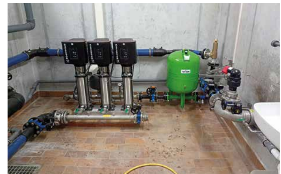
• Druckerhöhungsanlage Dörnthal
