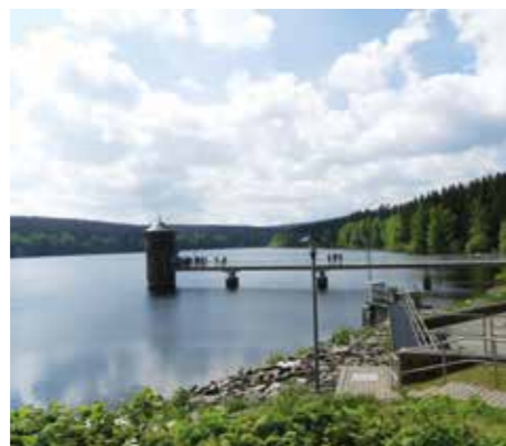
Foto: Südsachsen Wasser GmbH
