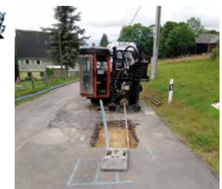
• Verlegung im Spülbohrverfahren
