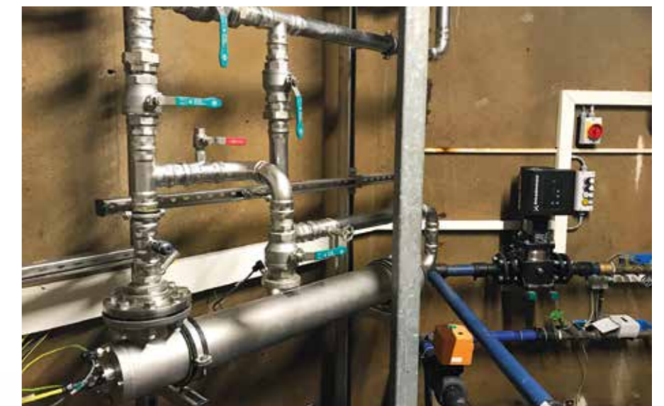
UV – Anlage TWA Nässe in Gelenau
